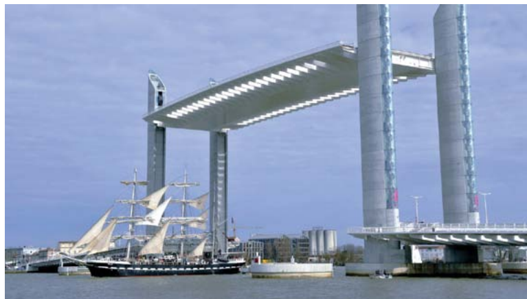
Puente Chaban-Delmas, que sirve al puerto de Burdeos, en el suroeste francés.
