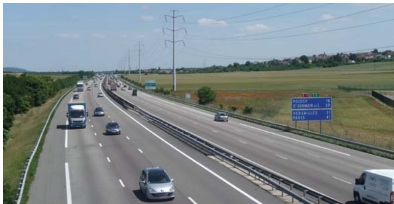
Autopista A-13 que comunica el puerto de Le Havre con París.
